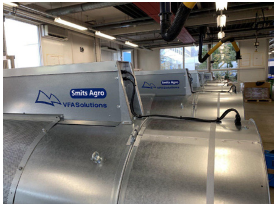
Foto 1,2 en 3: Bij Kipster, de duurzaamste kippenfarm van Nederland, paste VFA Solution het gesloten ionisatiesysteem ASPRA toe. Hier wordt 50% van het stof en de bacteriën in de stallen terugbracht en daarmee het binnenmilieu voor mens en dier behoorlijk verbeterd.
